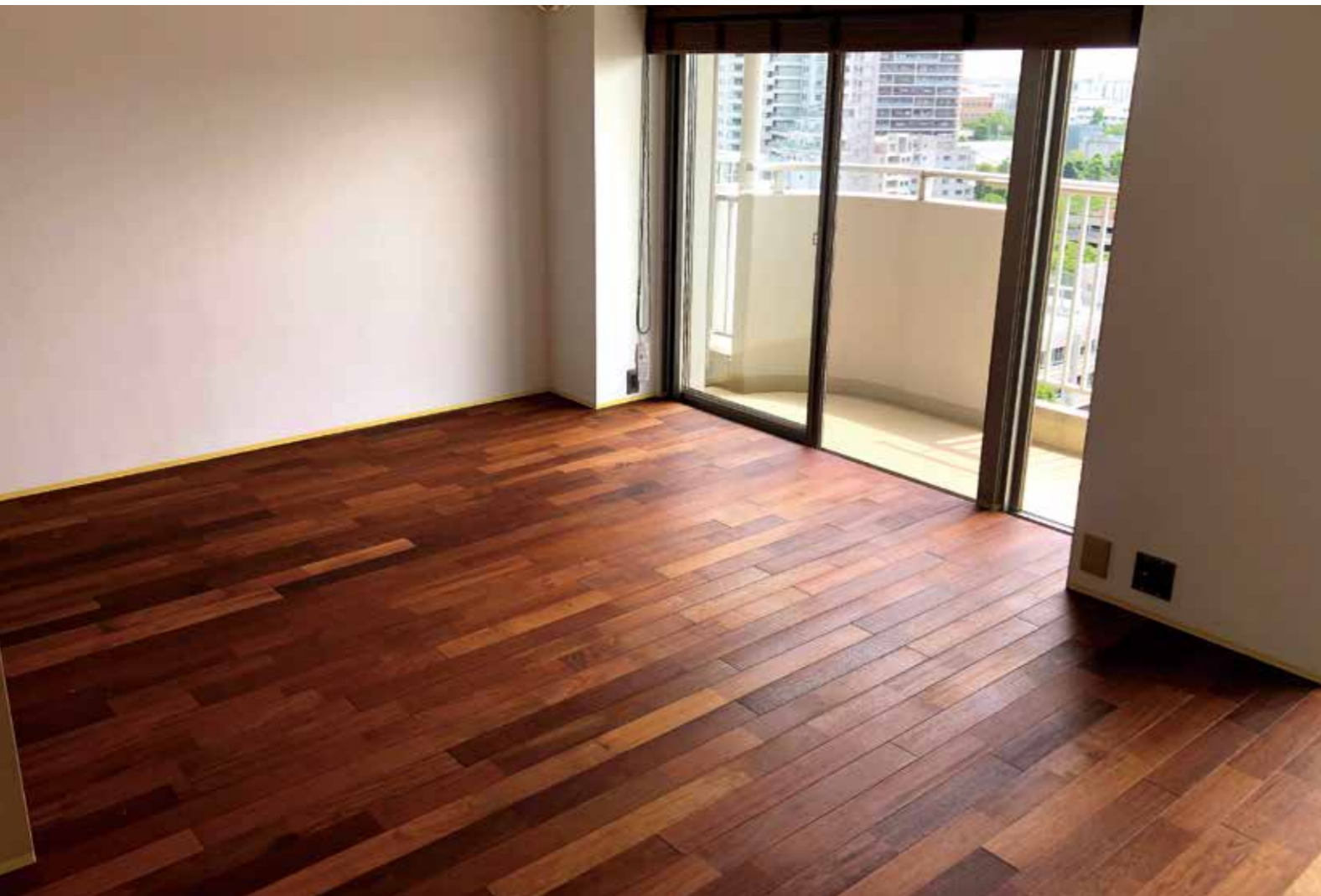
ユニ(低温式床暖房兼用) ナチュラル【オスモ自然塗装】15×90×1820 ST1US
