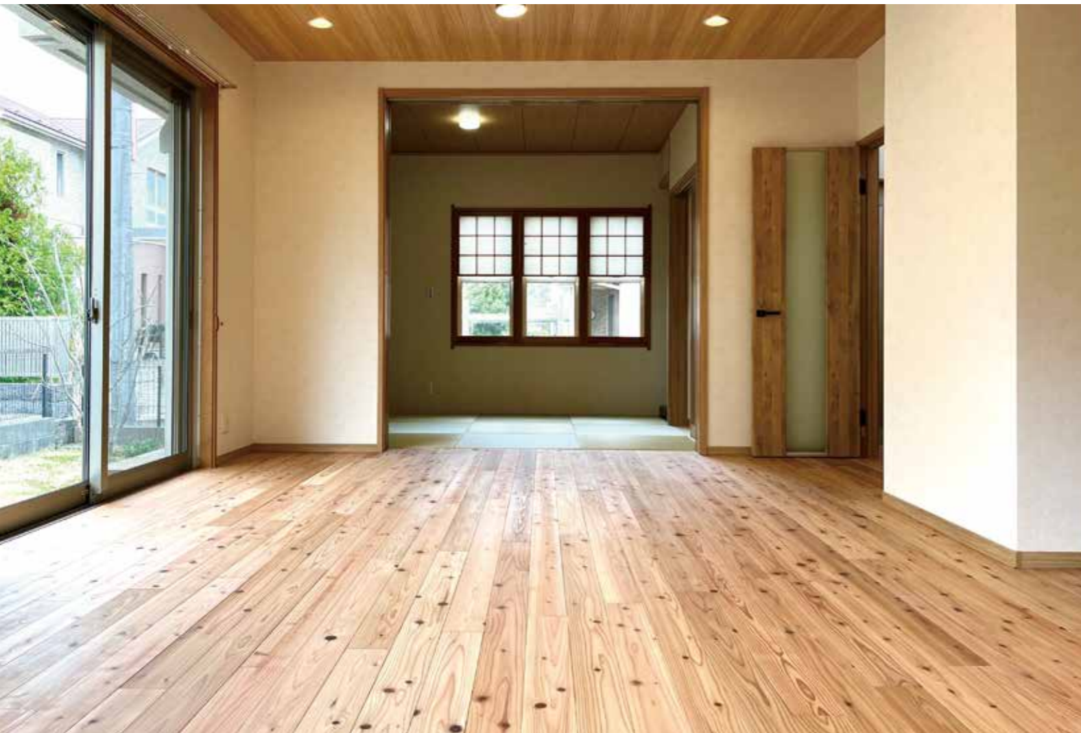
吉野杉一枚もの 通常品(赤)【無塗装】15×110×1820 SY10M+オスモ自然塗装 オーヴ株式会社
